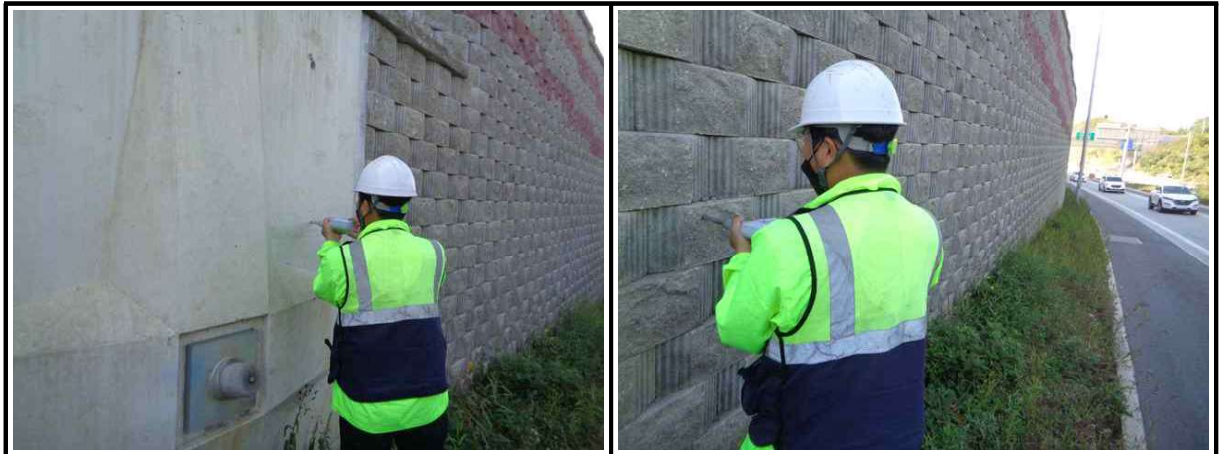
【그림 5.3.6】 슈미트해머를 이용한 반발경도시험 전경
